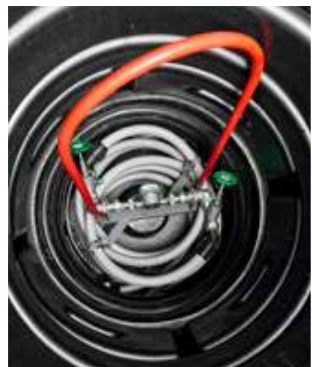
Innere des Schachtes
